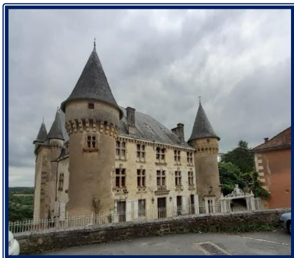
Château de Vaucocour, Thiviers
